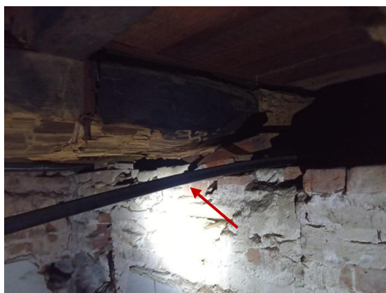
Figura 4 – Perda de seção na viga de madeira na região de apoio (cabeceira)
