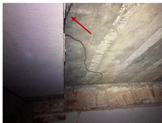
Figura 7 – Presença de caminho de cupins na laje do banheiro
