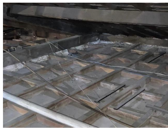
Figura 11 – Vista geral da estrutura de madeira do forro de gesso do salão de jantar
