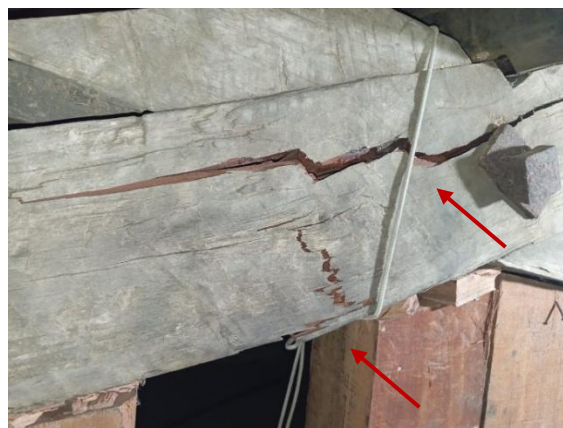
Figura 9 – Elemento estrutural de madeira rompido na cobertura
