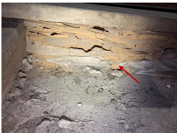
Figura 12 – Detalhe da estrutura do forro de gesso em estado avançado de degradação
