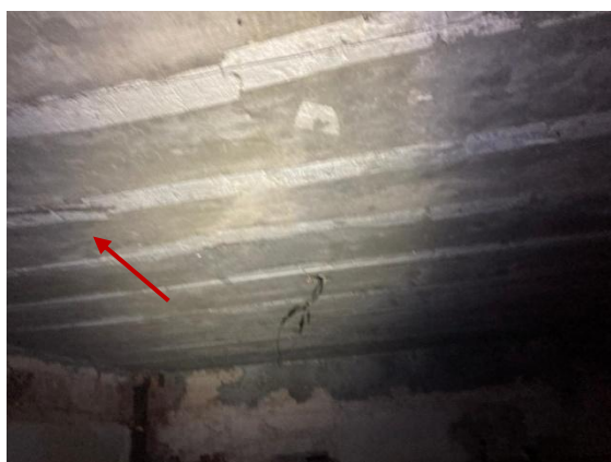
Figura 6 – Detalhe da corrosão da armadura na laje do banheiro
