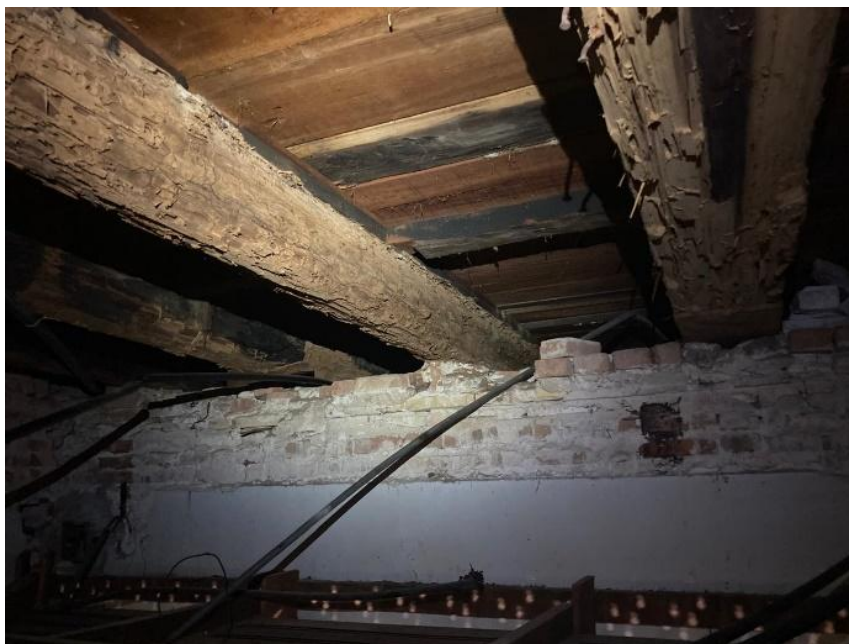
Figura 1 – Vigas de sustentação do piso do salão nobre com perdas significativas de seção transversal
