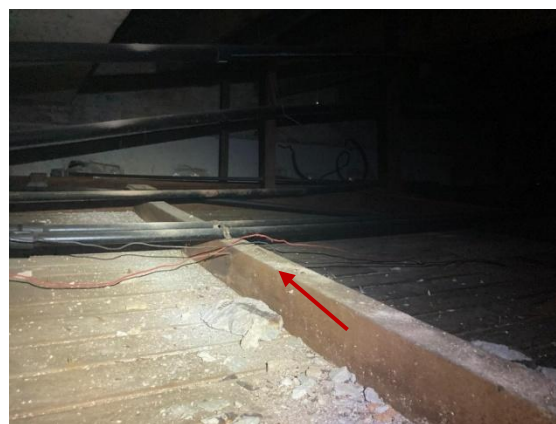
Figura 5 – Fiações elétricas soltas sobre o forro de madeira
