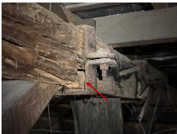
Figura 8 – Peça de madeira totalmente degradada, anteriormente reforçada com braçadeira metálica
