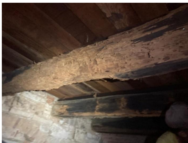
Figura 3 – Perda de seção significativa na viga de madeira localizada no centro do vão da sala multifuncional
