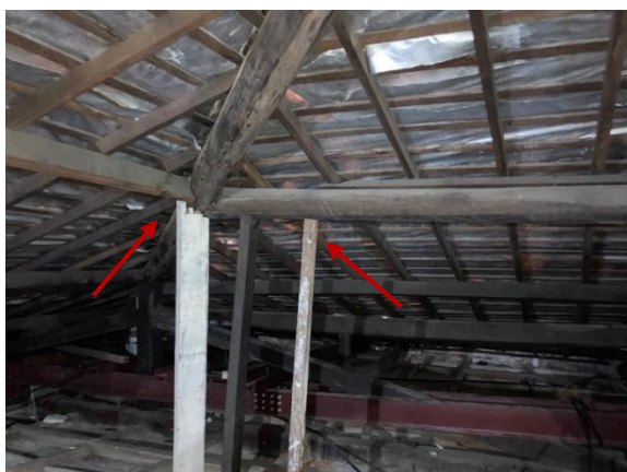
Figura 10 – Escoramentos paliativos instalados sob a cobertura, apresentando deslocamento
