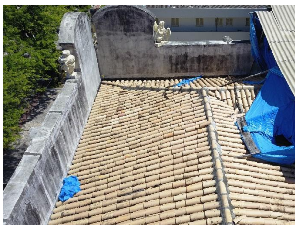
Figura 15 – Inexistência de SPDA
